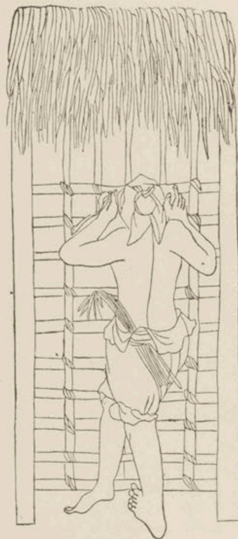
FIG. 32. — CONSTRUCTION D'UN MUR EN TERRE
