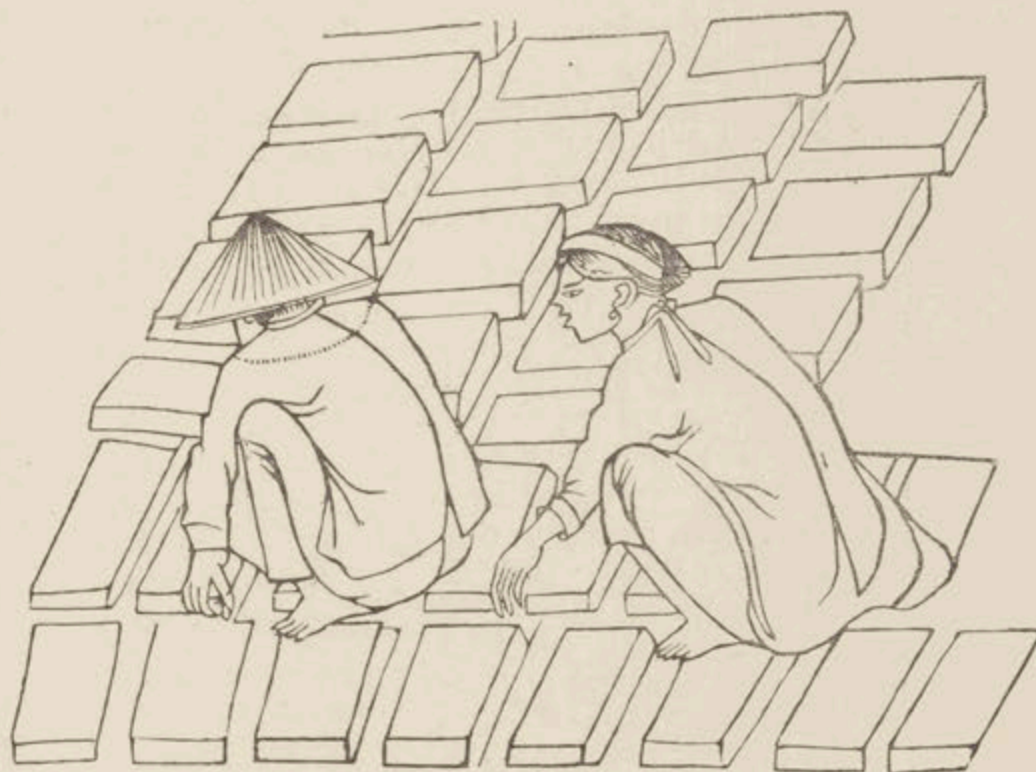
FIG. 31. — SÉCHAGE DES BRIQUES AU SOLEIL.
